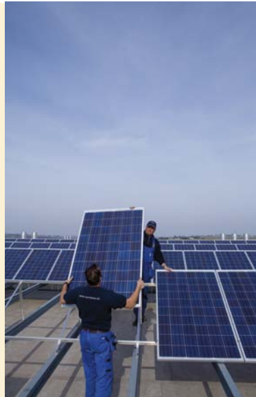
Montage von Solarmodulen auf dem Dach
